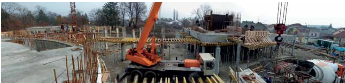
Pohľad na rozostavaný komplex
